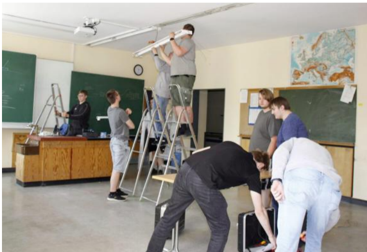
Umbau: die neuen Leuchtstoffröhren sparen 70 Prozent Energie
